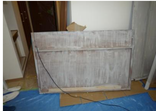
EM Diatomite flat applied on bed board
